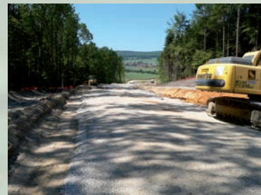
Neubau einer Bundesstraße
