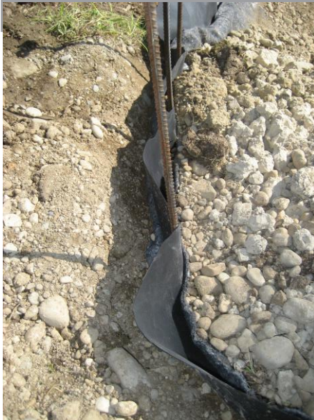
Links: Kapillarsperre beim Einbau
