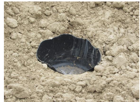
Unten: Pumpensumpf freigelegt
